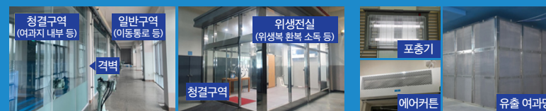
위생 전실 설치
