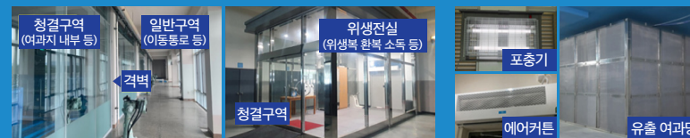
위생 전실 설치
