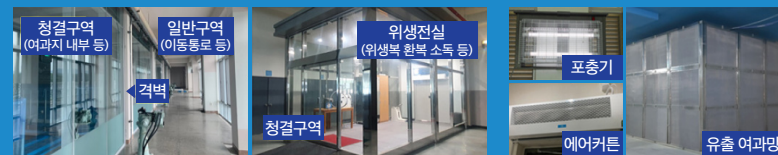
위생 전실 설치
