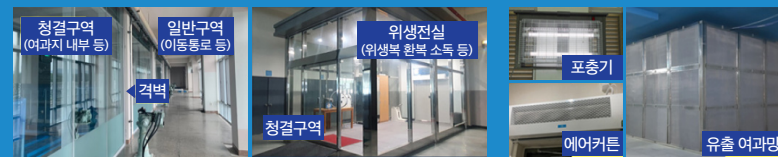
위생 전실 설치
