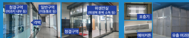
위생 전실 설치
