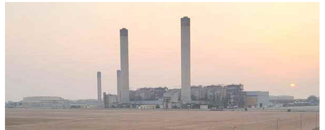
[사우디 제다 해수담수화 플랜트 전경]
