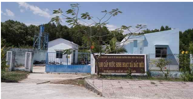
[까마우성 땃무이(Dat Mui) 상수도 시설 전경]
