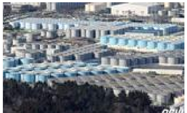
[도쿄전력 후쿠시마 오염수 저장탱크 전경]
