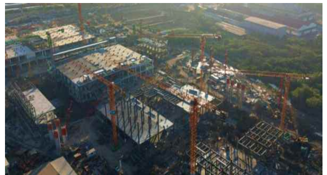
[‘26.3, EEC 데이터센터 건립 전경]
