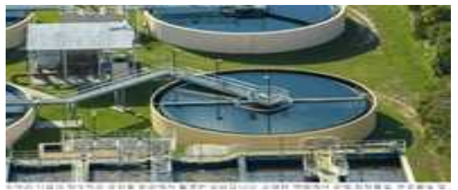
[워싱턴 Post Point 하수처리시설 전경]
