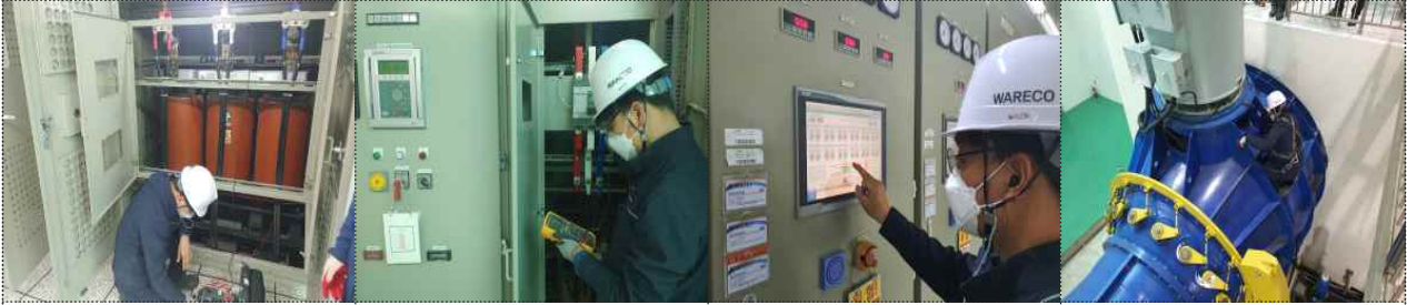
변압기 절연저항 측정
