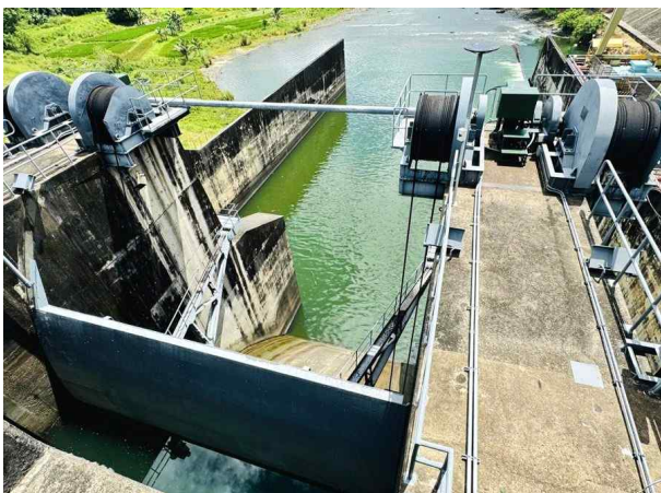
(마시웨이) 수문 설비 점검
