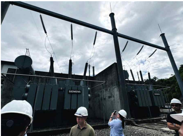
(카세크난) 옥외 전력설비 점검
