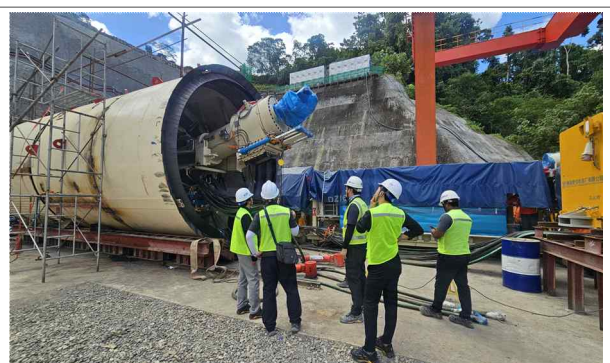
티나댐 공사현장 확인
