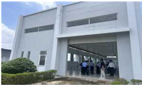
송수펌프동 계측·제어설비 점검
