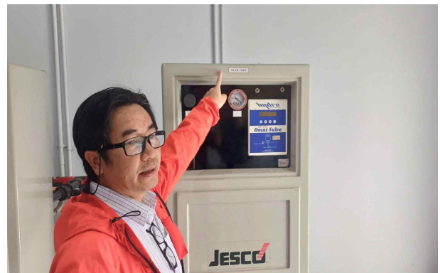
약품투입 센서 데이터 및 통신설비 확인
